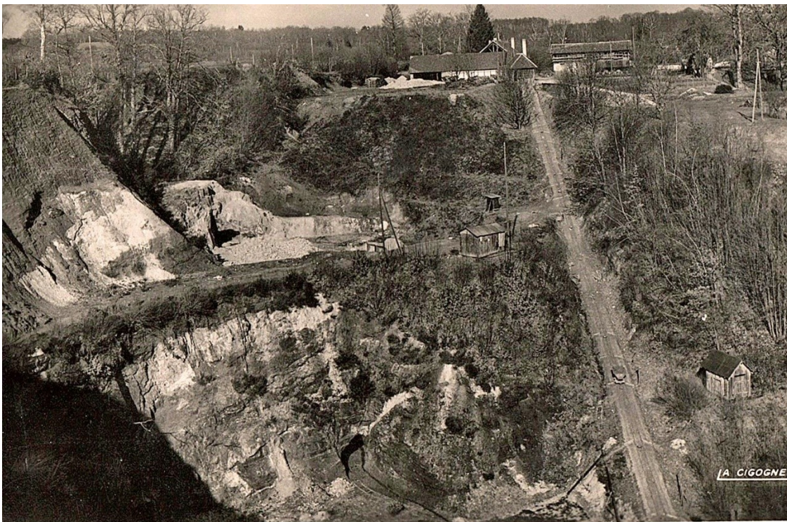
Carrière de Marcognac vers 1960 : extraction du feldspath. Le wagonnet est remonté par un treuil (carte postale).
